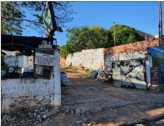
Foto 187: Entrada e local para entrega voluntária de resíduos passíveis de reciclagem
