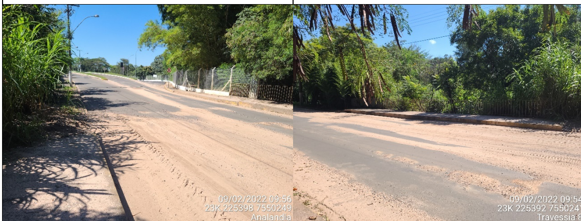
Foto 133: Assoreamento na Rua 4, próximo à entrada da cidade.
