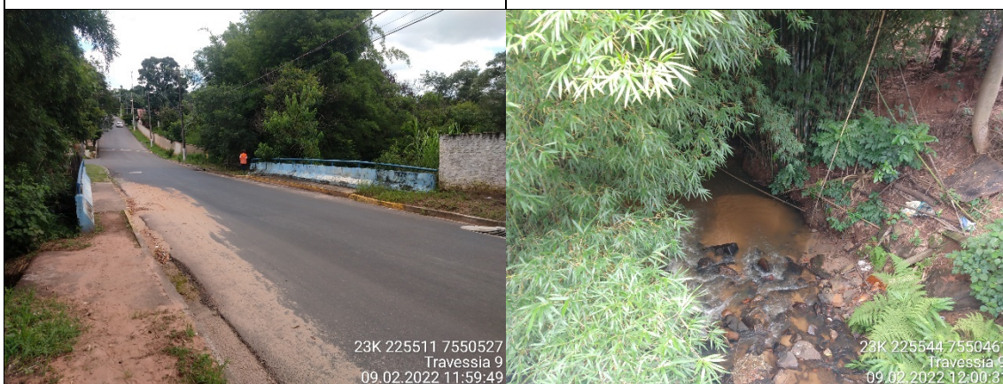
Foto 171: Travessia 9 – presença de sedimentos assoreados na rua asfaltada.
