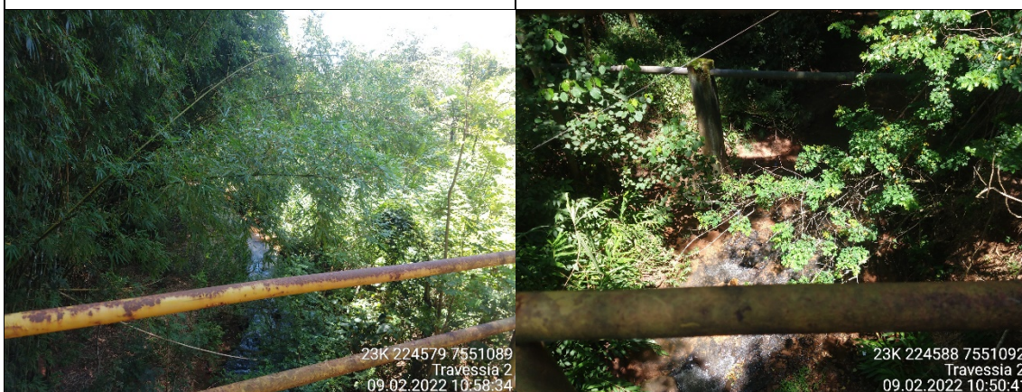
Foto 147: Traversia 2 - leito do rio (montante)
