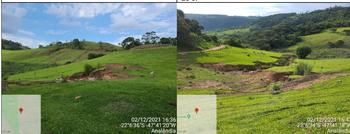
Foto 115: Feição erosiva próximo ao Morro do Camelo ao sul da via rural.
