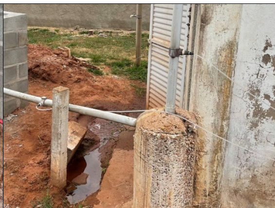
Foto 32: Conexões das mangueiras de adição de flúor e cloro do SAA Nova Analândia. (Fonte: Prefeitura Municipal de Analândia)
