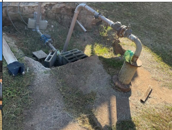
Foto 28: Laje Sanitária do poço 04 – SAA Jardim Nova Esperança (Fonte: Prefeitura Municipal de Analândia)
