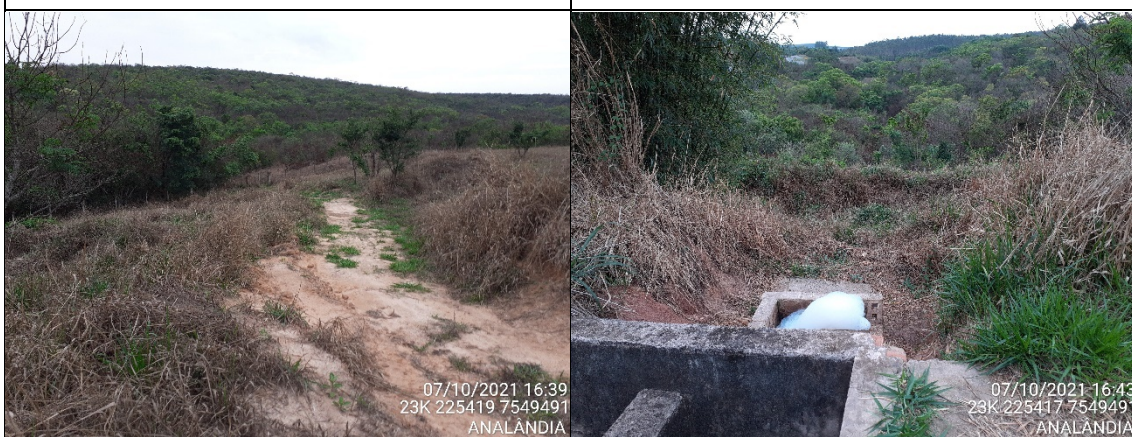
Foto 101: ETE - Caminho da tubulação de saída do efluente da ETE e vista da APP do Rio Corumbataí ao fundo.
