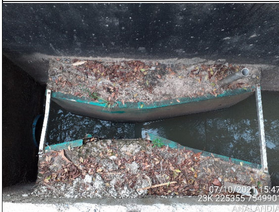
Foto 59: Estação Elevatória de Esgoto - Vista superior da Calha Parshall.
