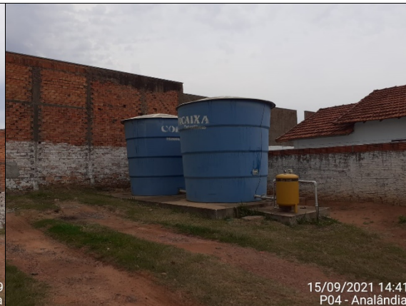
Foto 26: Poço 04, bomba e reservatórios adicionais – SAA Jardim Nova Esperança
