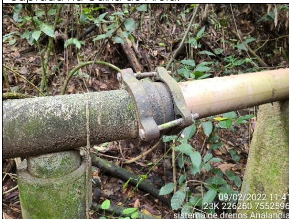
Foto 9: Trecho da tubulação com os dois materiais – cimento amianto à esquerda e PVC à direita
