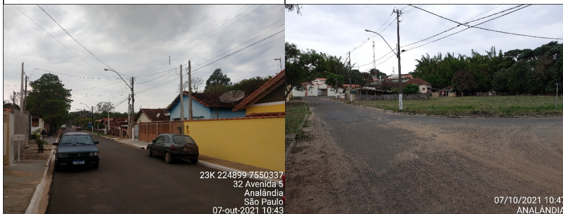
Foto 139: Residências na Av. 5 com lançamento irregular de esgoto e com ocupação em APP
