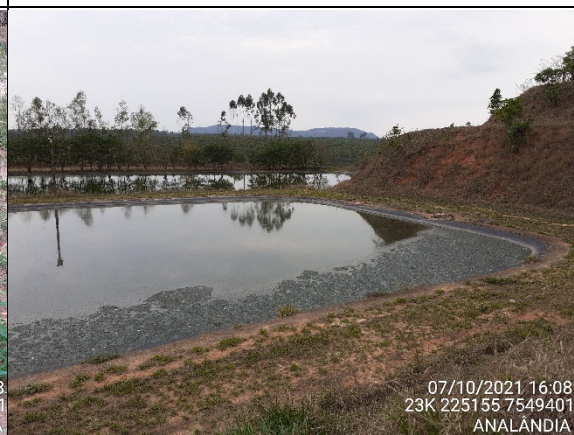
Foto 68: ETE – Lagoa Anaeróbia.
