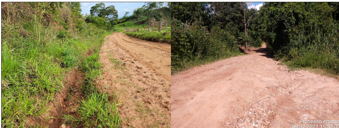
Foto 125: Sistema de drenagem da via rural próxima das feições erosivas.
