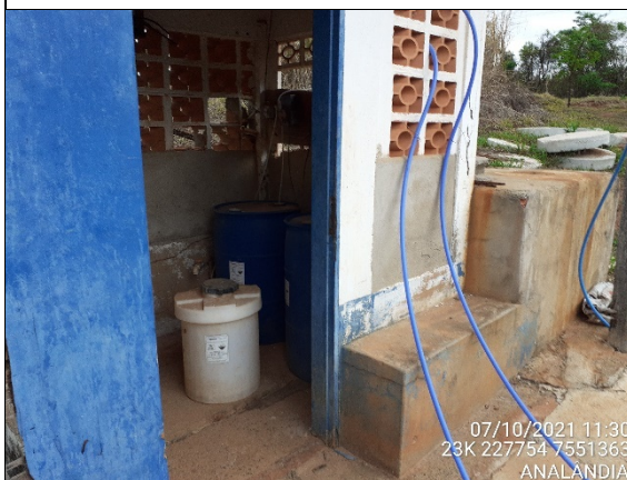
Foto 39: Casa de químicos da ETA desativada e do Poço 07 - SAA Portal das Samambaias.
