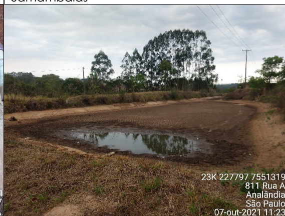
Foto 42: Lagoa de reservação da captação superficial no Córrego do Retiro desativada - SAA Portal das Samambaias
