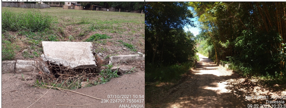
Foto 141: Boca de Lobo na Av. 3.
