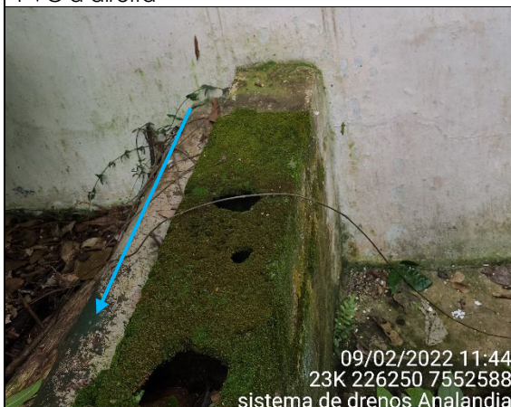
Foto 11: Saída da adutora de água captada da Caixa de Areia
