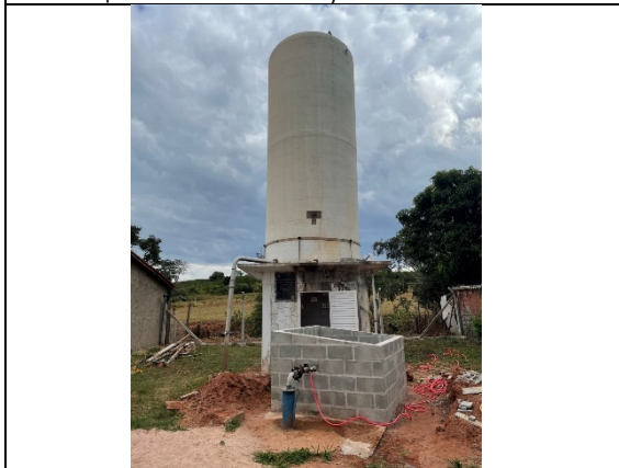
Foto 29: Poço 05 e reservatório do SAA Nova Analândia (Fonte: Prefeitura Municipal de Analândia).
