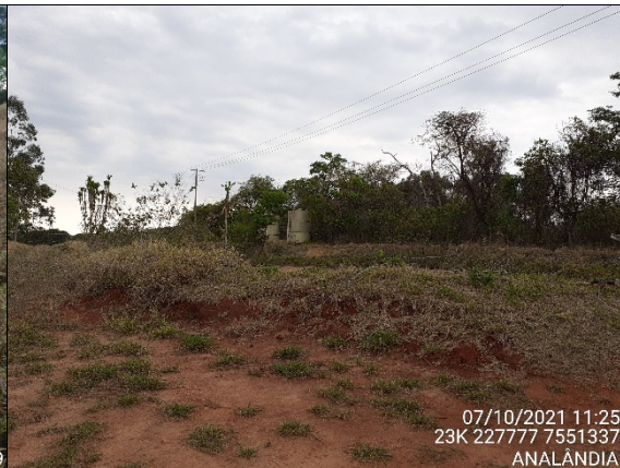
Foto 44: Antiga ETA e reservatórios elevados de 33 m³ ao fundo - SAA Portal das Samambaias.
