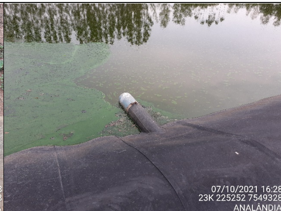
Foto 88: ETE - Tubulação de saída do efluente da lagoa facultativa
