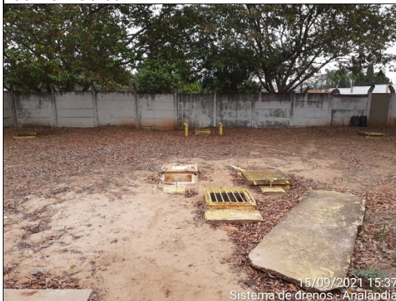
Foto 45: Terreno com reservatórios enterrados de 150 m³ cada do SAA Drenos.
